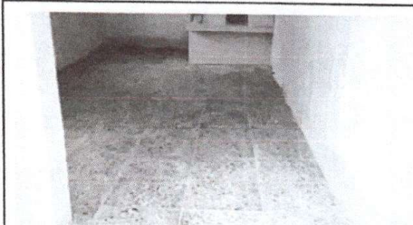
Foto 6: proceso de sustitucion de piso ceramico de granito.
