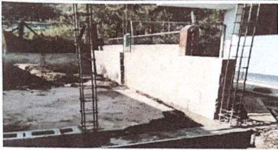
Foto 1: se sustituyo pared de lamina por pared de block
