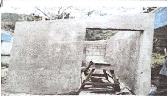
Foto 5: proceso de sustitucion de plancha de concreto
