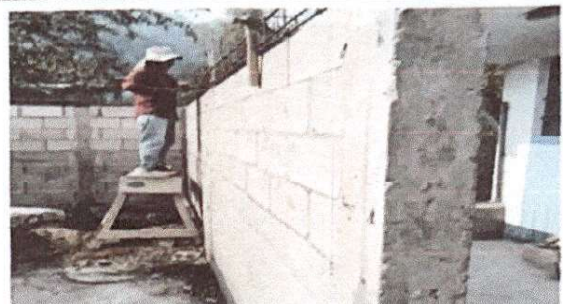
Foto 2: proceso de finalizacion de las paredes de block
