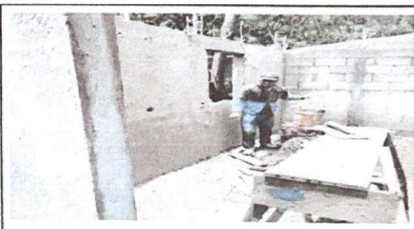
Foto 4: finalizacion de repeyo de paredes
